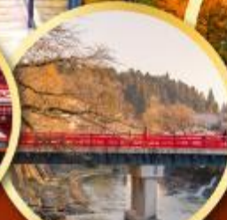
สะพานนากะบาชิ
